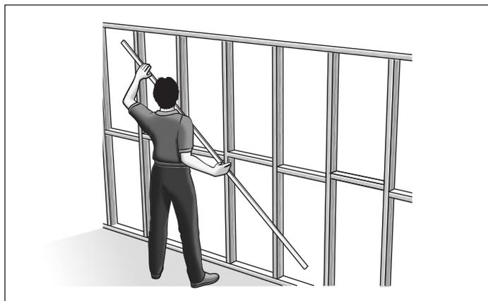
**FIGURE 1 FRAME STRAIGHTNESS**
